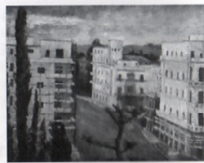
Mario Matai, Demolizioni in via Ripetta , 1936. Cortese & Lisanti
